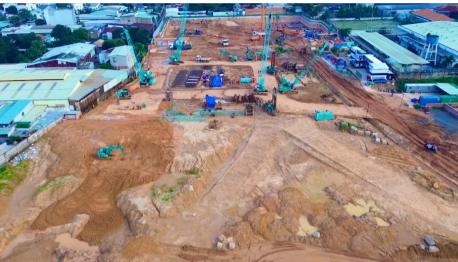
Hình ảnh thi công tổng thể dự án
