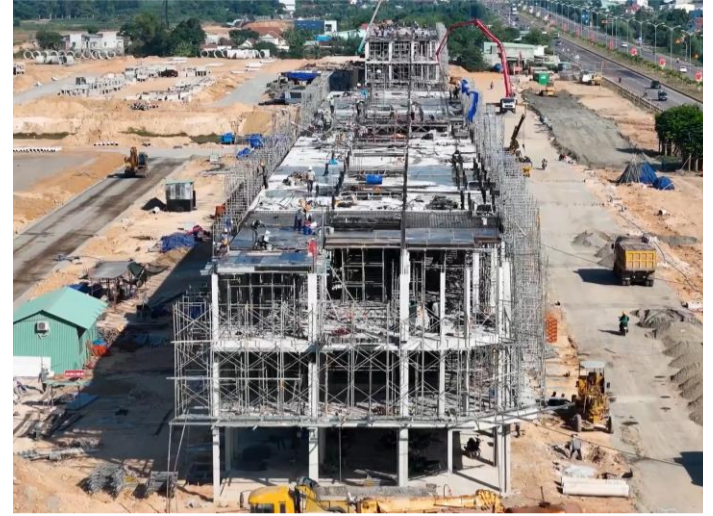
Thi công đổ bê tông tầng 3
