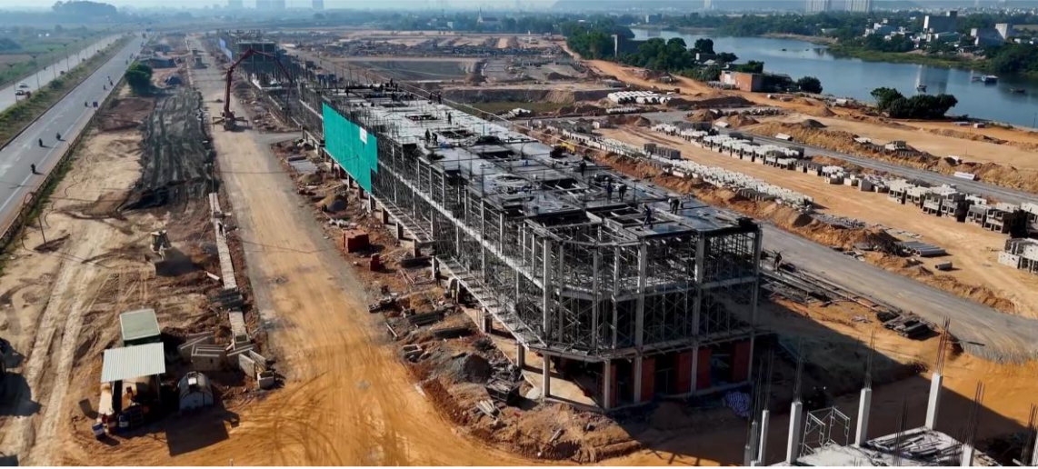
Hình ảnh thi công tổng thể dự án
