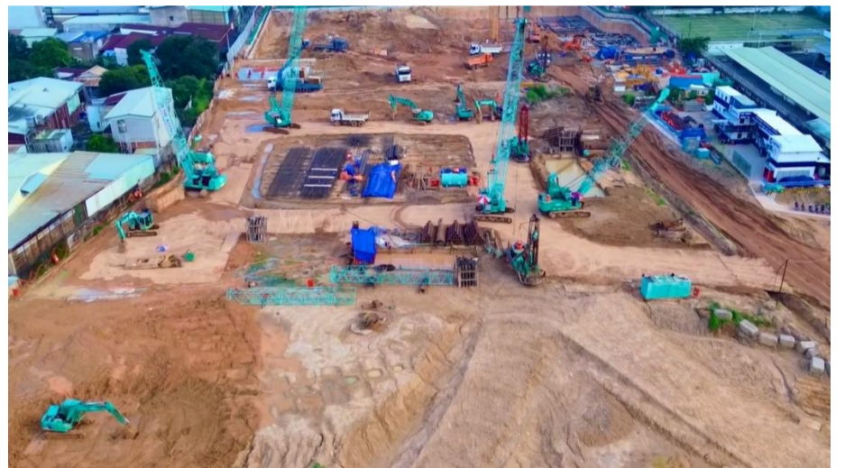
Đang thi công tường vây tháp A2, A3
