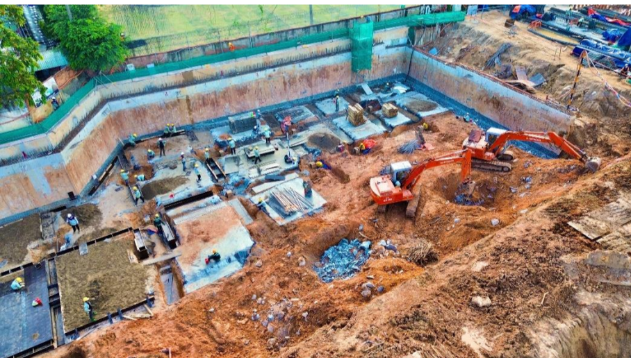
Đào đất, thi công tầng hầm B1 tháp A1
